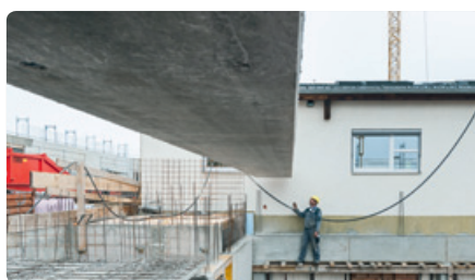
Omegaceutical, Anbau einer Lagerhalle
