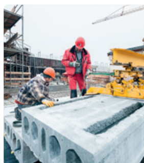
Die fertig, mit Beton vergossene Spannbetondecke
