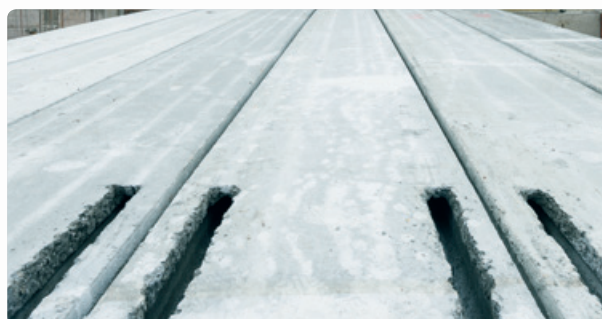
Fertig installierte Spannbetondecke auf der Baustelle. Bis zu 600 m 2 pro Tag möglich.
