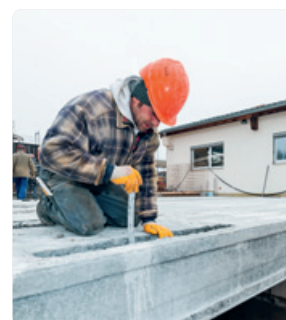
Bereit zum Anschluss an das Heiz-/Kühlsystem
